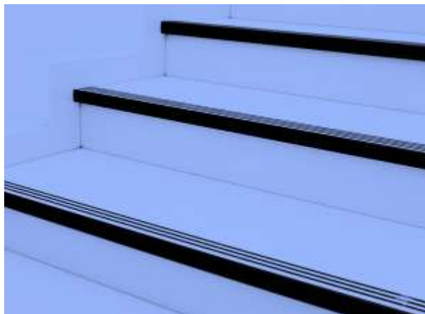
Figura 29. Señal contrastante en nariz de escalones o cambios de nivel para reducir riesgo de caída
